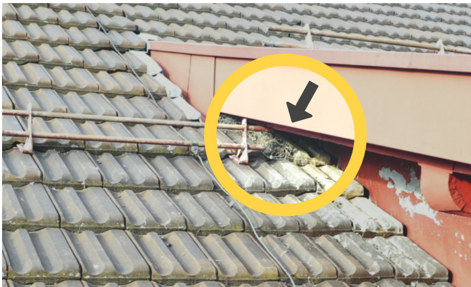
Photographie des endroits par lesquels les pigeons pénétraient dans les combles du bâtiment : la zone est aujourd'hui protégée par un treillis.
